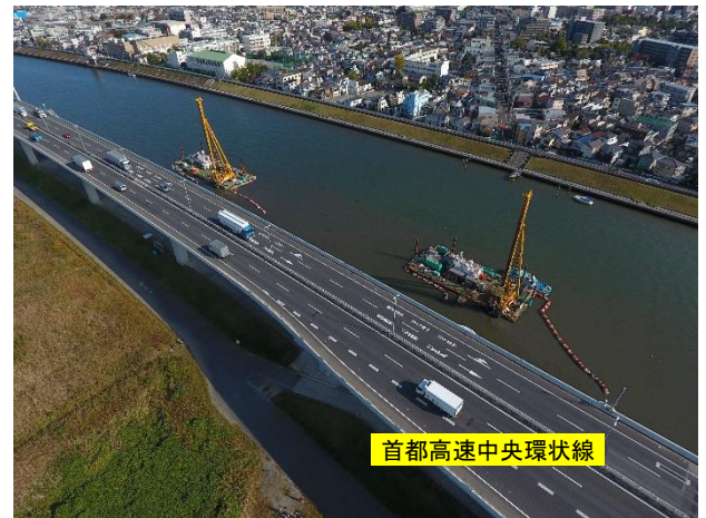
写真-1 現場全景
