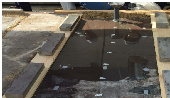
写真-2 充填性確認試験状況
