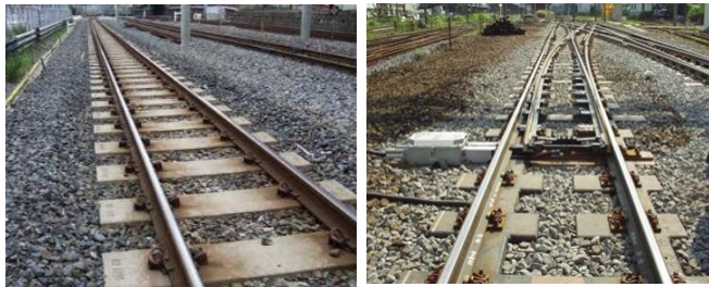
図 1 省力化軌道（左）と次世代分岐器（右）
