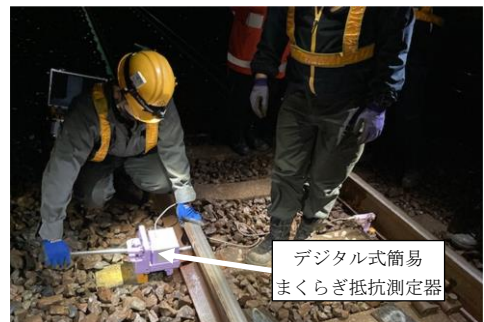
図2 道床横抵抗測定状況
