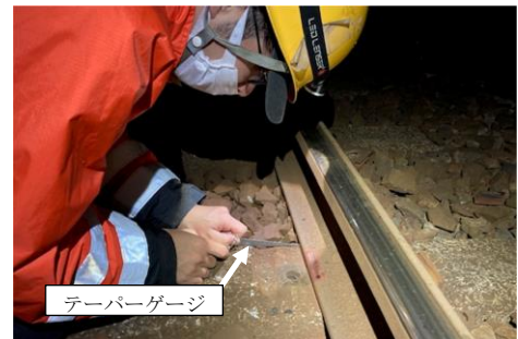
図1 浮き量の実測状況
