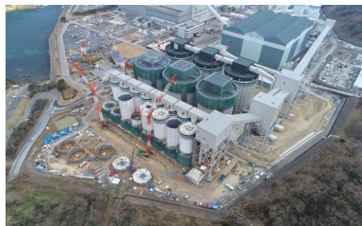
写真-1 現場全体写真(2022年2月25日撮影)
