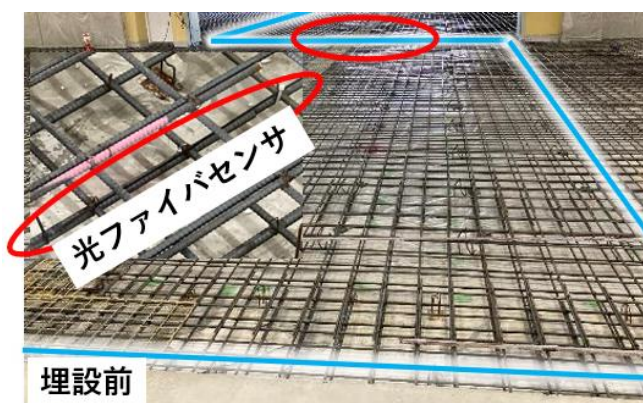
図-1 RC スラブに対する光ファイバセンサの敷設状況
