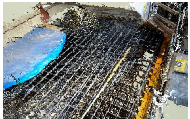
図-6 撮影したデータから生成した点群（B1F 部）
