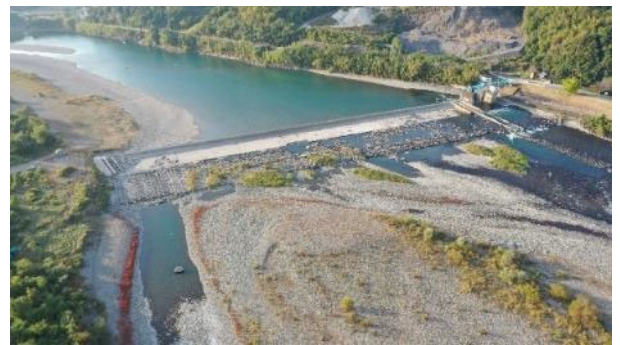
図-2 実証した現場の UAV 写真
