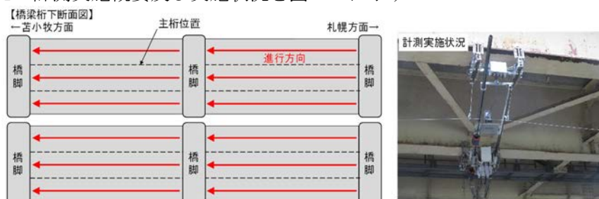
図-3 主桁把持式レーザー測量実施概要及び実施状況
