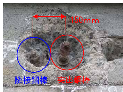
写真-2 隣接 PC 鋼棒
