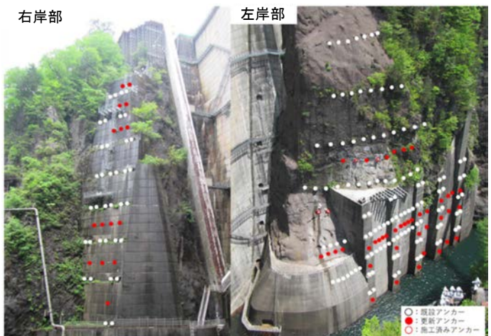
図-1 既設・更新アンカー配置図
