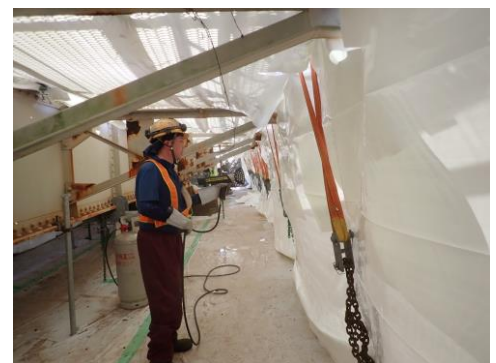
写真-2 養生状況
