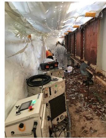
写真-5 足場および養生
