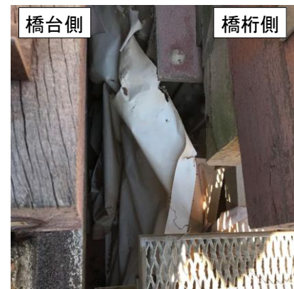
写真-6 足場端部の養生状況
