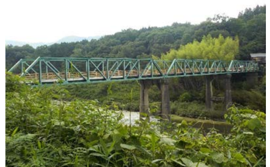
写真-1 笹瀬橋の全景
