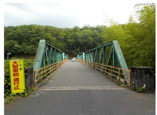
写真-2 ポニーラス構造
