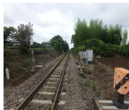
写真-3 対策施工前
