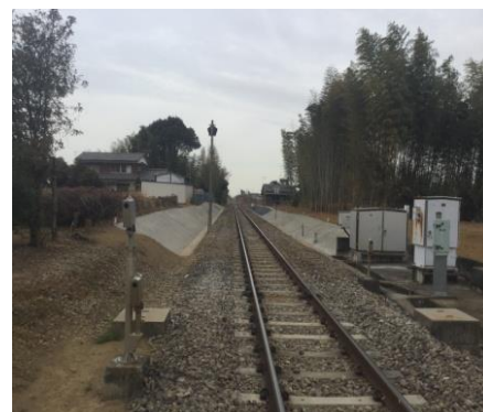
写真-4 対策施工後
