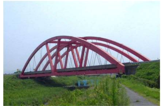
写真-1 対象橋梁全景
