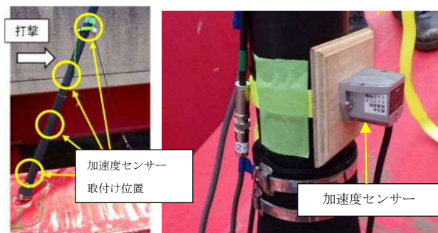
写真-3 加速度センサー取付状況
