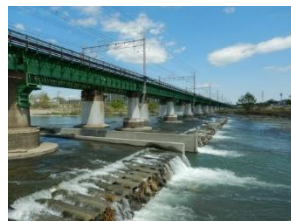
図-1 橋りょう全景
