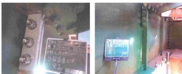
図3 中間補剛材の上端溶接部の補修工事状況
