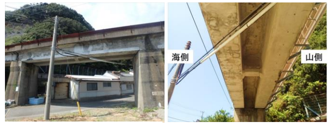
図 1 海側からの橋桁全景
