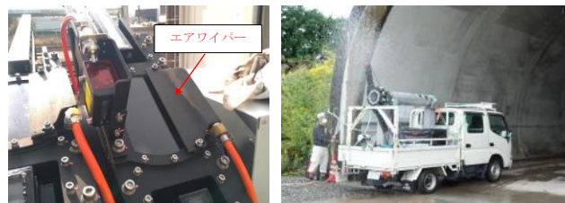
写真-3 雨天対策と散水試験状況
