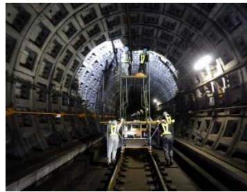
写真-1 打音点検
