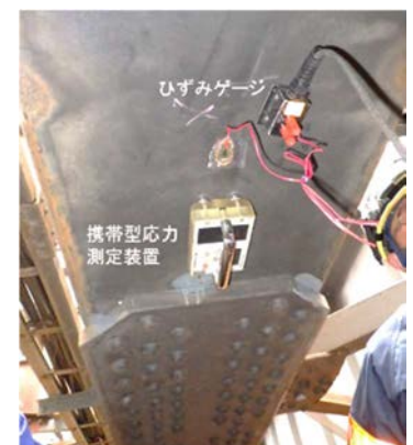
写真-3 測定状況
