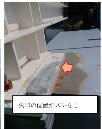
写真-3 クランプの点検状況
