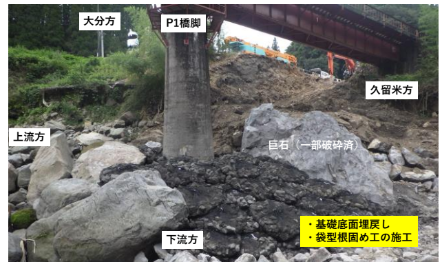
図2 応急対策状況
