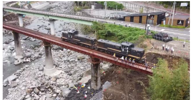
写真1 載荷試験状況
