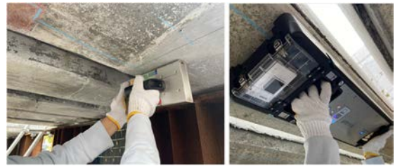
写真3 実劣化PC桁での計測状況
