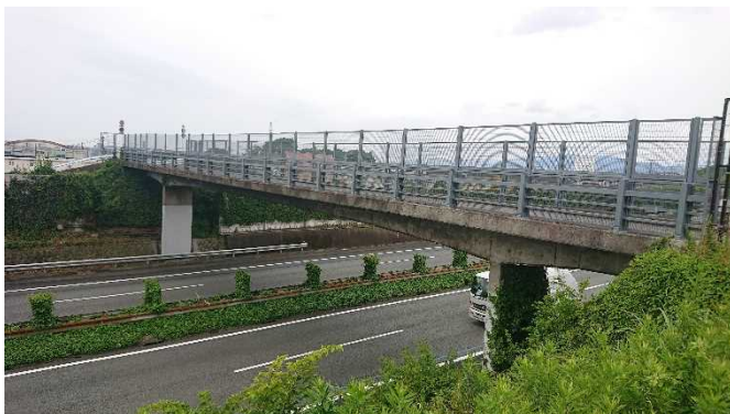
図 1 対象橋梁と同型の跨道橋(OV)
