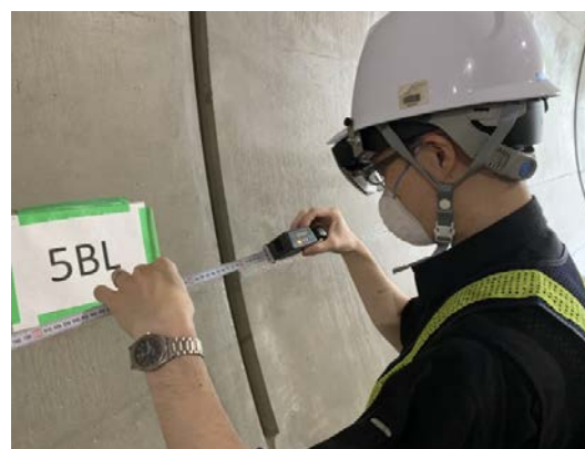
写真-1 現場における測定状況
