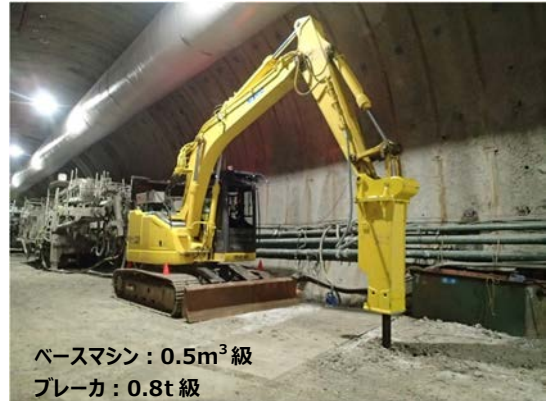
写真-1 無人化施工システム搭載油圧ブレーカ
