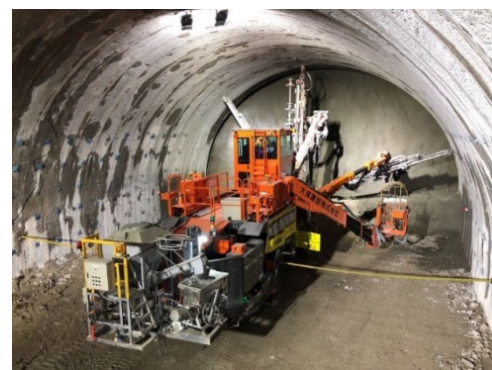
図-8 2号機での施工状況
