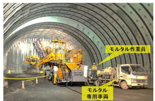
図-2 1号機での機械配置
