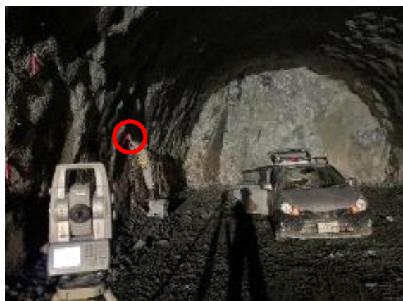
写真-3 リフレクター測定状況(当初)
