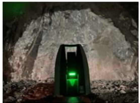
写真-1 切羽測定状況
