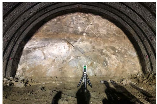
図-3 現場での計測状況
