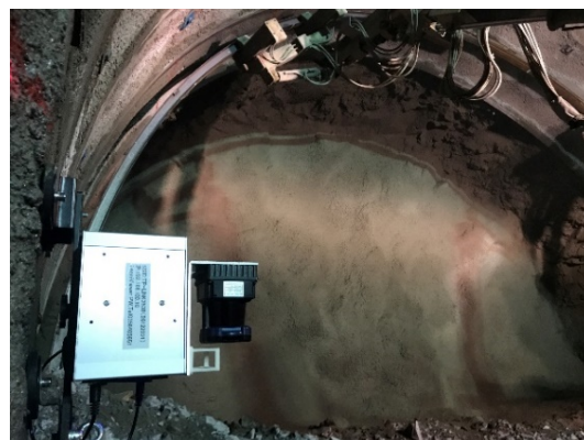
図-3 簡易 3D スキャナー設置状況
