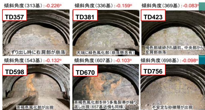
写真-1 切羽写真
