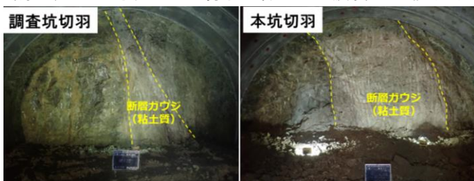
図-3 調査坑TD630m付近の切羽写真(左)と本坑TD550m付近の切羽写真(右)
