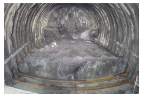
写真-1 インポートストラット施工状況
