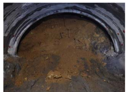
写真-7 切羽写真 (No.4 付近)
