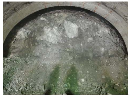
写真-5 切羽写真 (No.52 付近)
