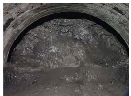
写真-6 切羽写真 (No.35 付近)
