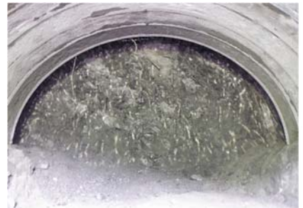
写真-4 切羽写真 (No.70 付近)
