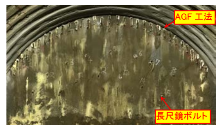
写真-4 補助工法実施状況
