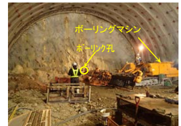
写真-1 水平ボーリング状況 表-1 室内試験結果
