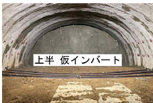
写真-2 上半仮インバート施工状況
