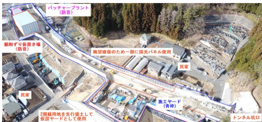
写真-1 終点側坑口部施工ヤード全景
