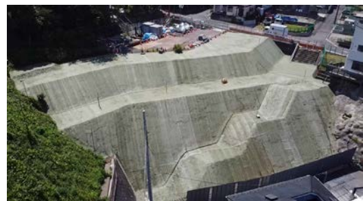
写真-1 低土被り区間(改良盛土施工後)
