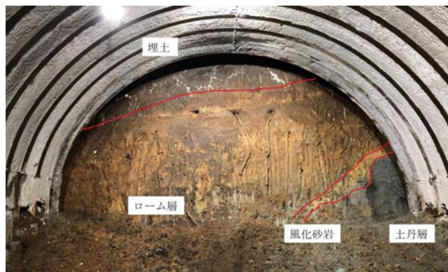
写真-2 切羽写真 (先進坑 TD=139m)
