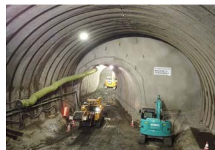
写真-4 中央導坑坑口部
