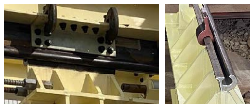
図-3 継手部拡大写真
