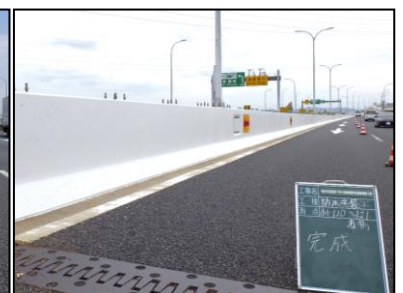
写真-7 施工完了
