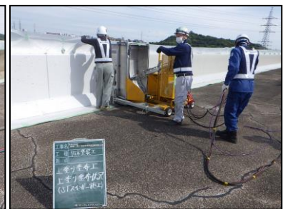
写真-5 上塗り状況
