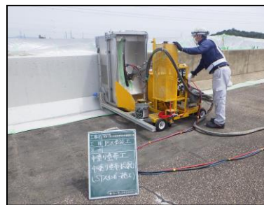
写真-4 中塗り状況
