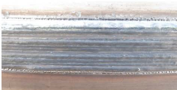
写真-4.1 溶接完了後の表面状態
