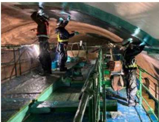
写真-3 フラップリフトでの作業状況
