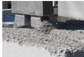
写真-1 切削状況
