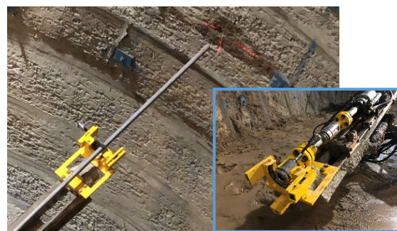
写真-1 レーザ照射付きセンタライザ
