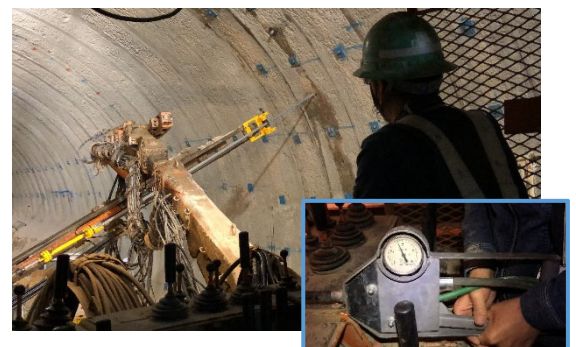
写真-4 試験状況写真
