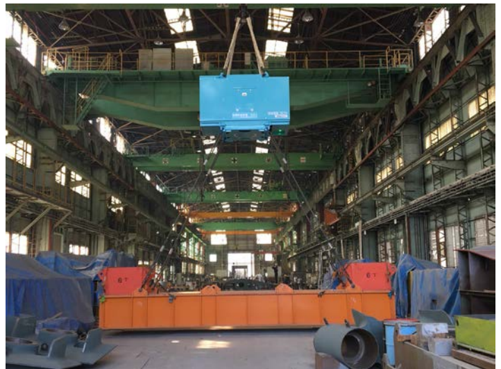
写真-2 大型吊荷旋回制御装置の試験状況
