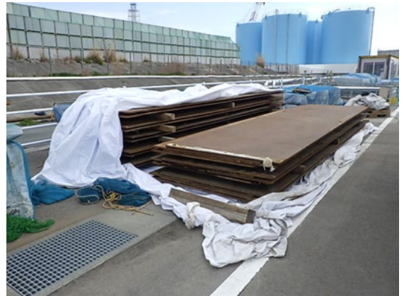
写真-1 敷鉄板集積状況
