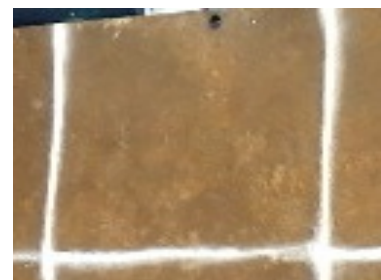
写真-2 敷鉄板表面状況
