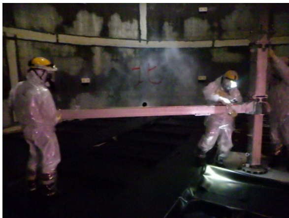
写真-2 タンク内作業状況
