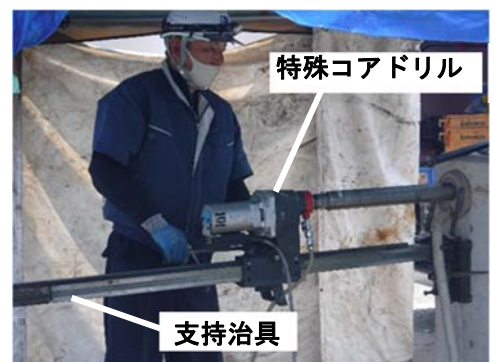
写真-1 特殊コアドリルによる削孔状況
