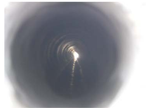
写真-2 貫通状況 (削孔の直線性の確認)
