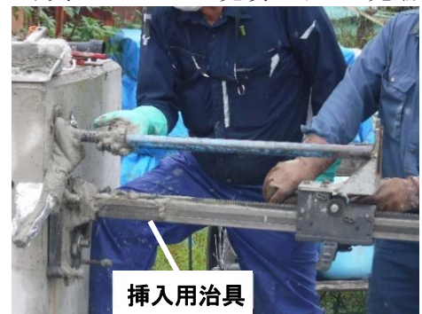
写真-4 ポストヘッドバーの挿入状況
