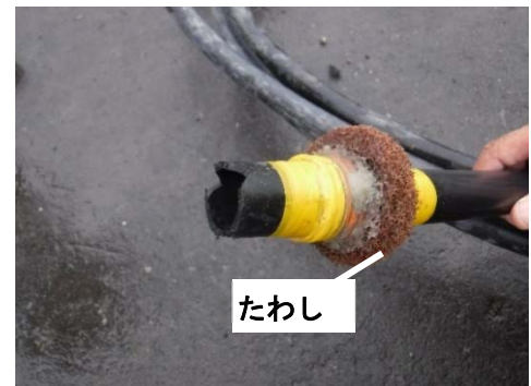
写真-3 モルタル充填パイプの先端
