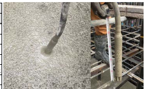
写真-1 実施工 打設翌朝の加振による性状確認
