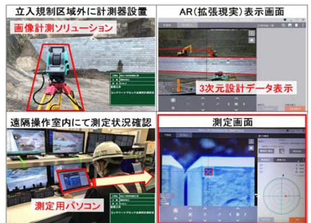
図-6 ブロック出来形測定状況(遠隔操作室)
