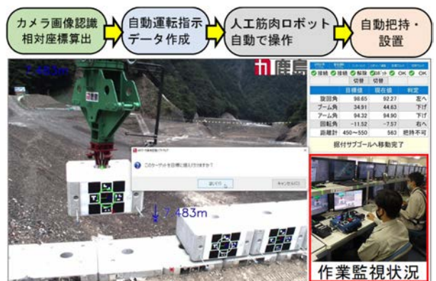
図-7 ブロック設置の自動化施工状況
